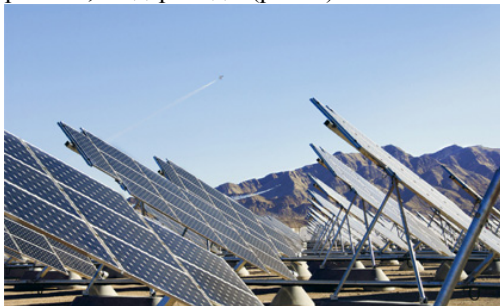
Рисунок 1 - В штате Невада установлена крупнейшая в США солнечная электростанция
